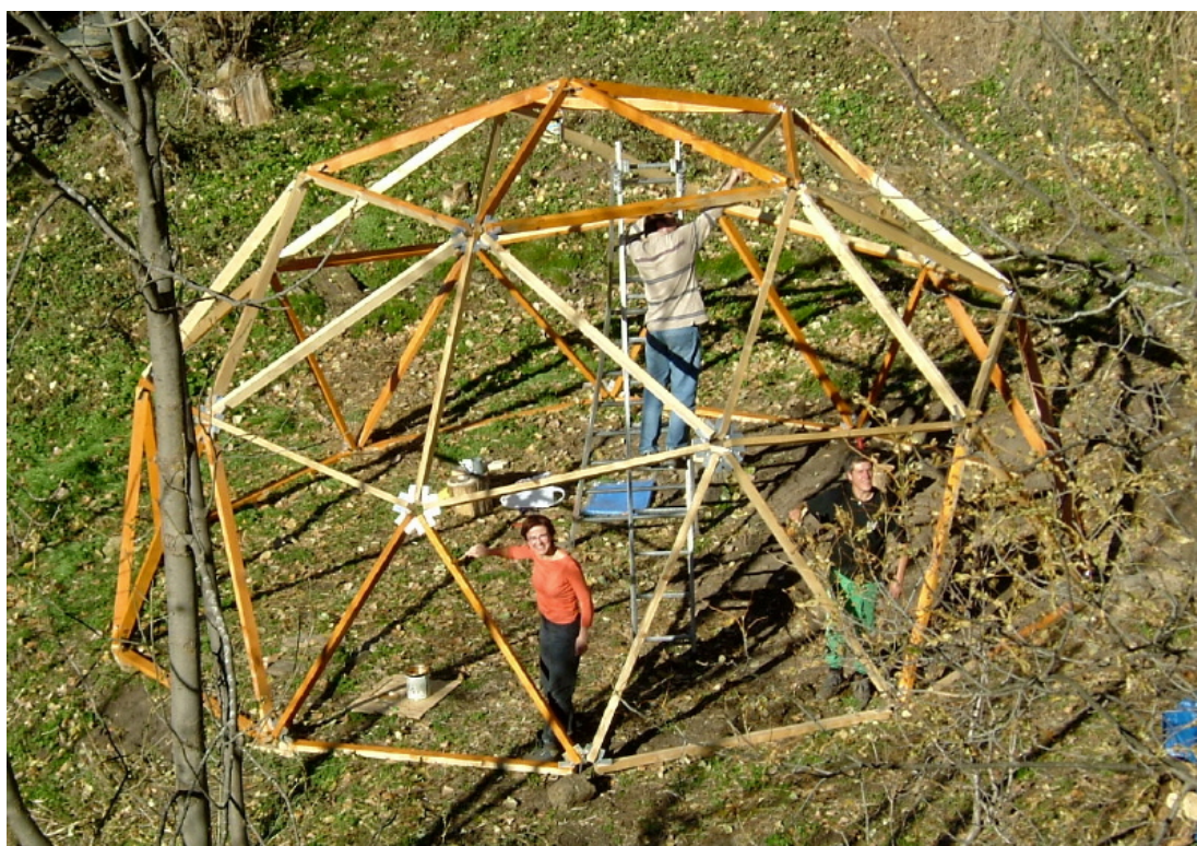
Figura 12. Construcció de una cúpula geodèsica al Pallars (Catalunya). Projecte de Recerca d'Oriol Batiste. Font: Oriol Batiste
